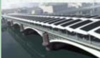
Blackfriars Bridge (London, Großbritannien) mit Solarzellen von Panasonic
